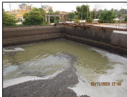
ภาพที่ 2.10 Equalization Tank
