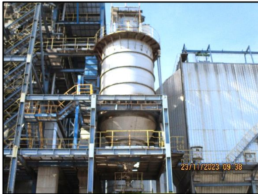
ภาพที่ 2.4 ไซโลรวบรวมเถ้าเถ้า (Fly Ash) ภายในโครงการ
