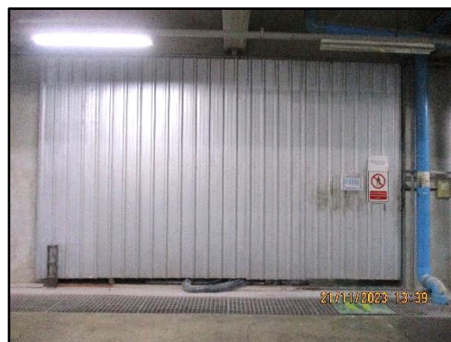
ภาพที่ 2.59 ห้องครอบเสียงเครื่องจักรภายในโครงการ
