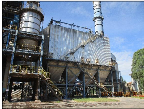
ภาพที่ 2.1 ระบบบำบัดมลพิษทางอากาศแบบไฟฟ้าสถิตย์ (ESP)
